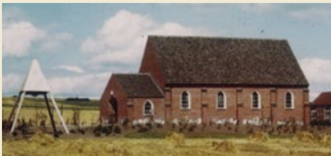
Dronningborg Kirke anno 1954.
