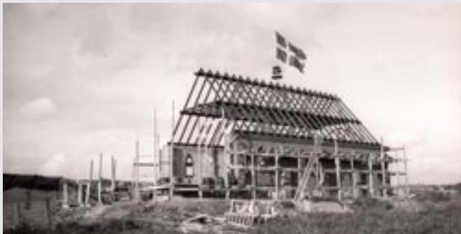
Rejsegilde på kirkebyggeriet i Dronningborg - 1953.
